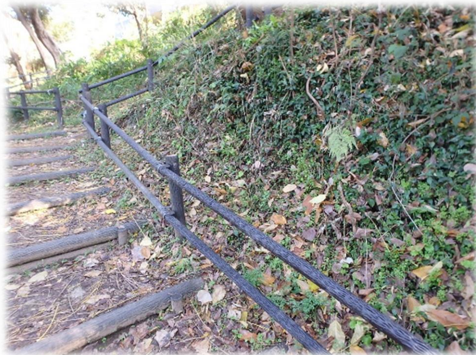
修繕後の状況
