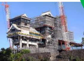
復旧中の熊本城
