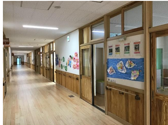
県産木材を使用した内装
