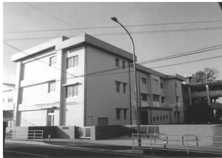
託麻東小学校校舎
