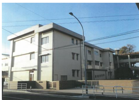
託麻東小学校校舎
