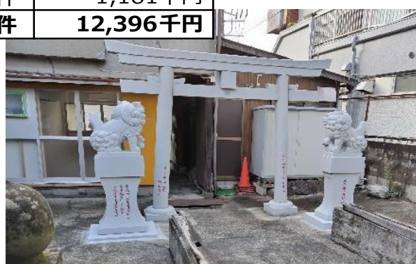
白梅天満宮(狛犬及び台座の復旧) R5年10月工事完了
