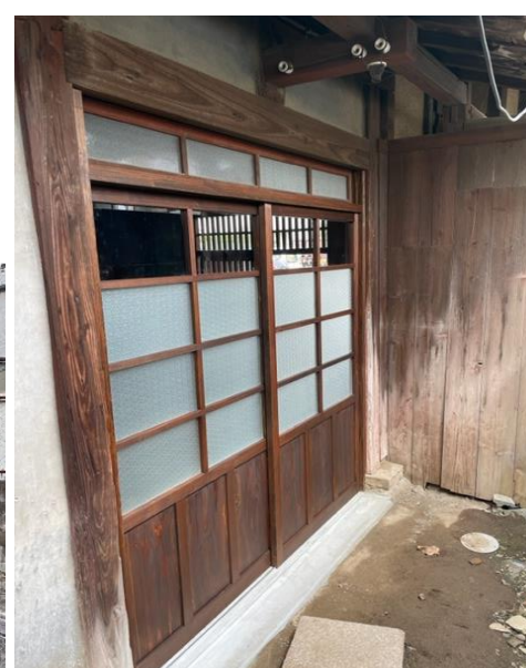
今村家住宅(建具等の改修) R5年10月工事完了
