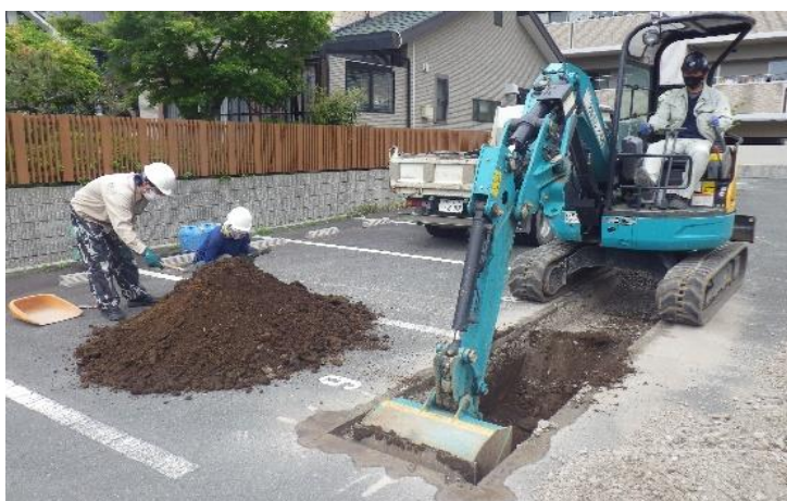
確認調査(重機による掘削状況)
