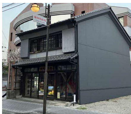
新町会館(補強、外壁の改修) R7年3月工事完了
