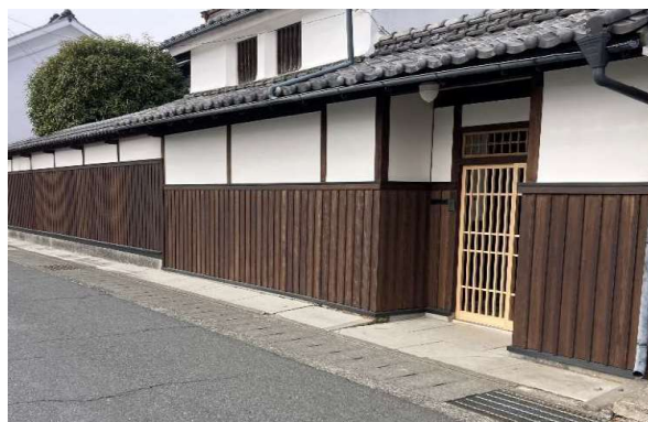
吉村邸(塀の改修) R7年3月工事完了
