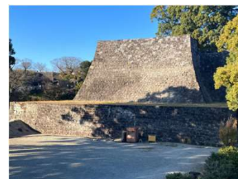
復旧が完了した飯田丸五階櫓石垣
