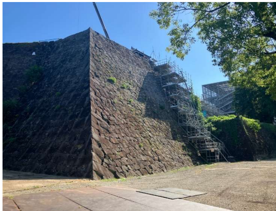
平櫓台石垣の復旧工事
