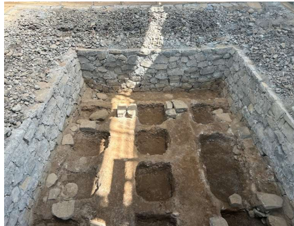
宇土櫓五階櫓の解体保存工事
