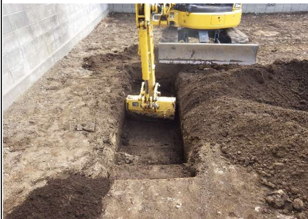
確認調査(重機による掘削状況)
