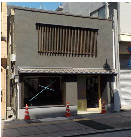
町屋(唐人町)外観改修工事
