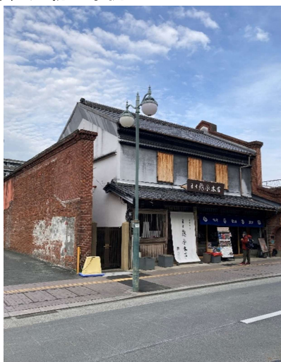
景観重要建造物: 西村邸
