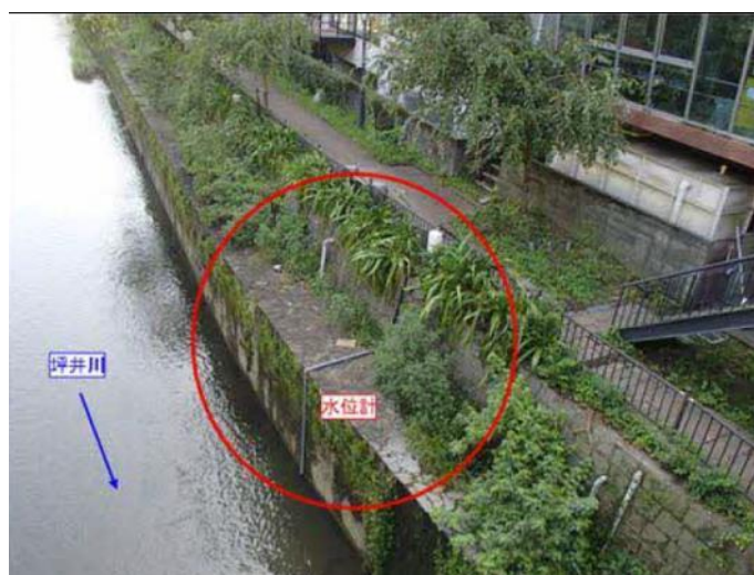
▲水位計の設置
