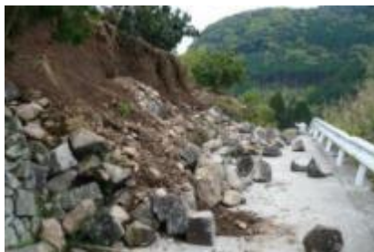
▲平山地区みかん園地の法面崩落
