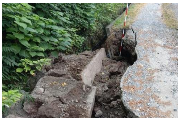
▲ため池の堤体の亀裂、陥没 (平成28年)
