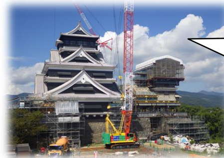
復旧工事中の熊本城
