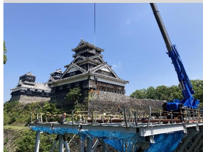
宇土櫓（復旧工事中）
