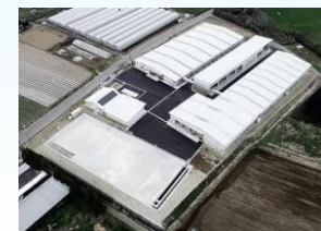
熊本市東部堆肥センター
