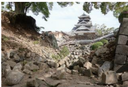
▲熊本城 石垣の崩壊
