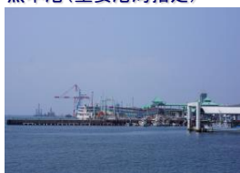
熊本港（重要港湾指定）
