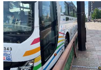
バスの走行状況：道路構造物と近接
