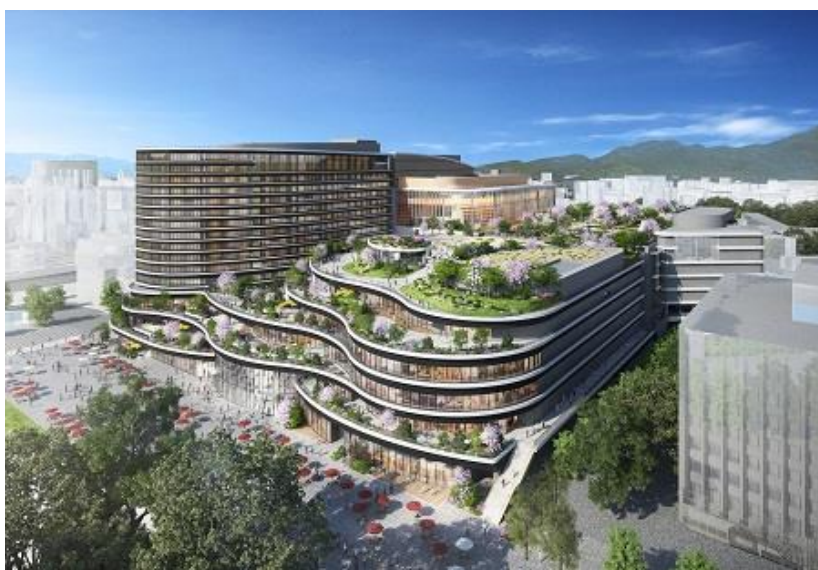
▲メインターミナル（桜町バスターミナル）の整備
