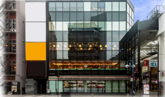
⑩KK下通銀座クロスビル
