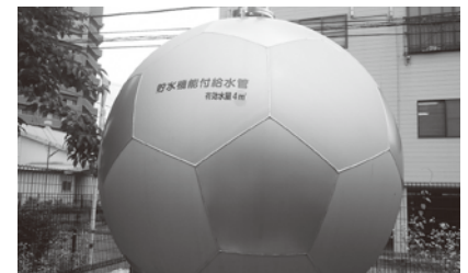
小中学校に設置されている貯水機能付給水管
