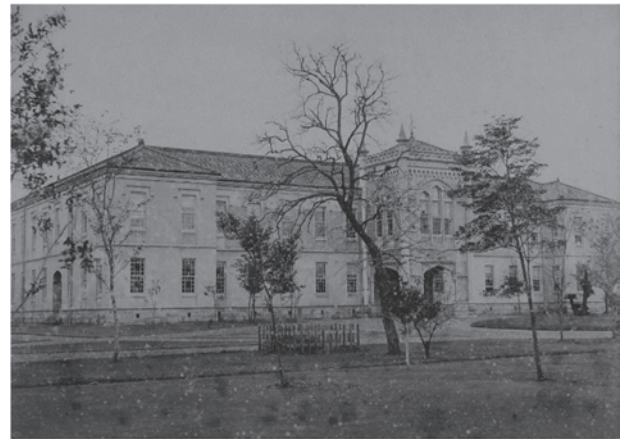
図4 5代目県庁舎の写真
