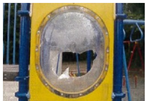
パネル部分の破損
