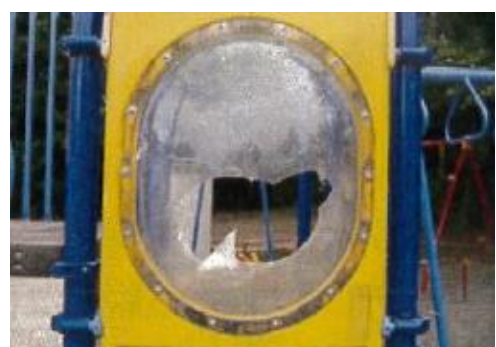
パネル部分の破損
