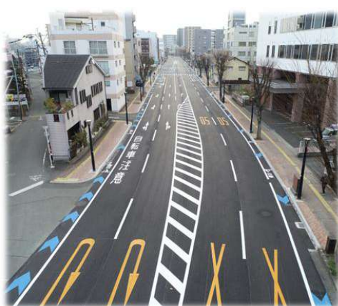
▲熊本停車場線(R4整備)
