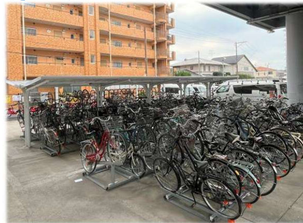
▲改修後の新水前寺駅駐輪場
