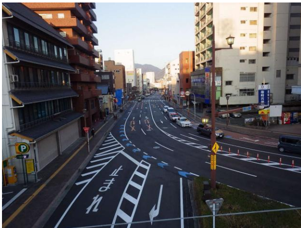
写真 熊本玉名線（藤崎宮付近）の整備状況
