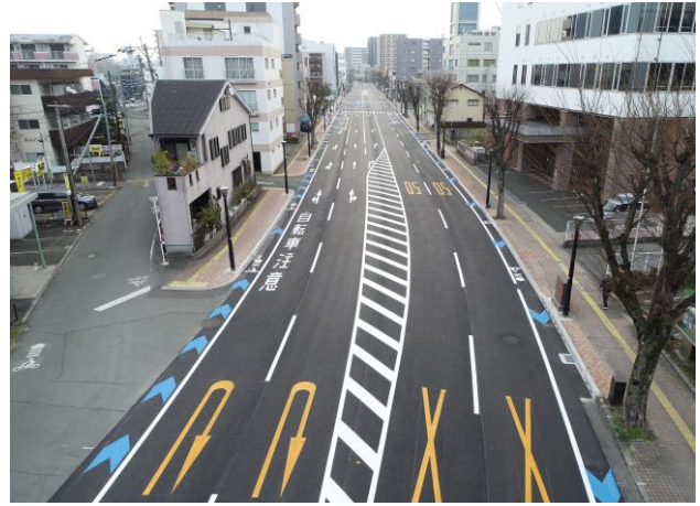
写真 熊本停車場線の整備状況
