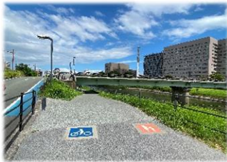
写真 白川ちやりんぼみち (代継橋～新代継橋)
