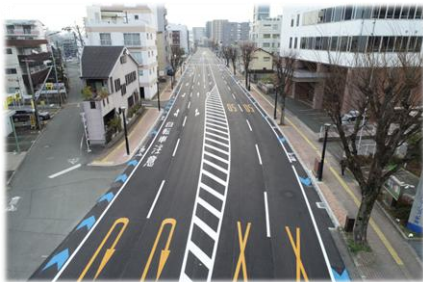
写真 主要地方道 熊本停車場線
