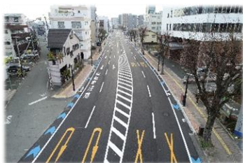
写真 主要地方道 熊本停車場線
