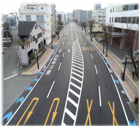
▲熊本停車場線(R4整備)
