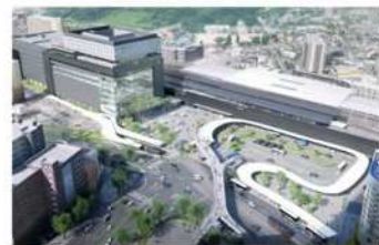
熊本駅（白川口駅前広場）
