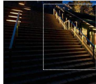
●●手摺に照明を内蔵し、足元を照らすことで視認性が向上し、安心して階段を上ることができます。また、グレアが抑制されていることで、階段を見上げる際の眩しさが軽減されます。
