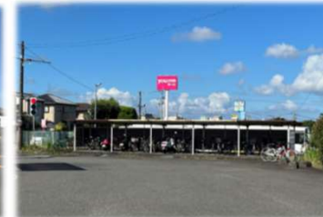
▲西側駐輪場(現況)
