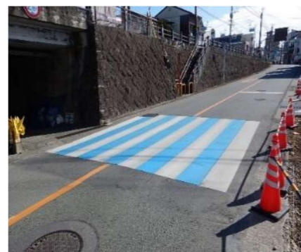
写真 事故防止対策（横断歩道のカラー舗装）
