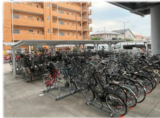
▲改修後の新水前寺駅駐輪場
