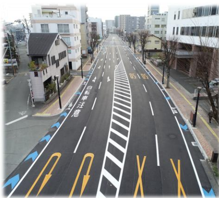
▲熊本停車場線(R4整備)
