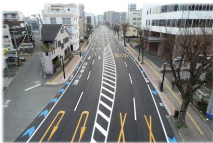
写真 主要地方道 熊本停車場線
