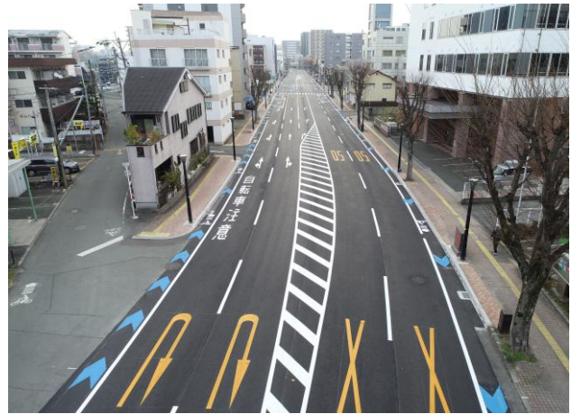
写真 熊本停車場線の整備状況
