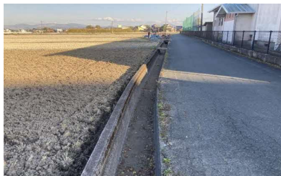
②敷地北側道路及び側溝
