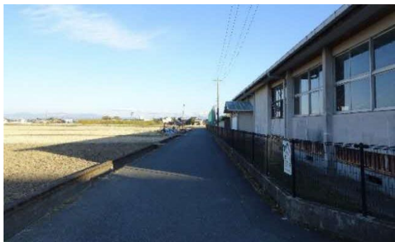
①敷地北側道路
