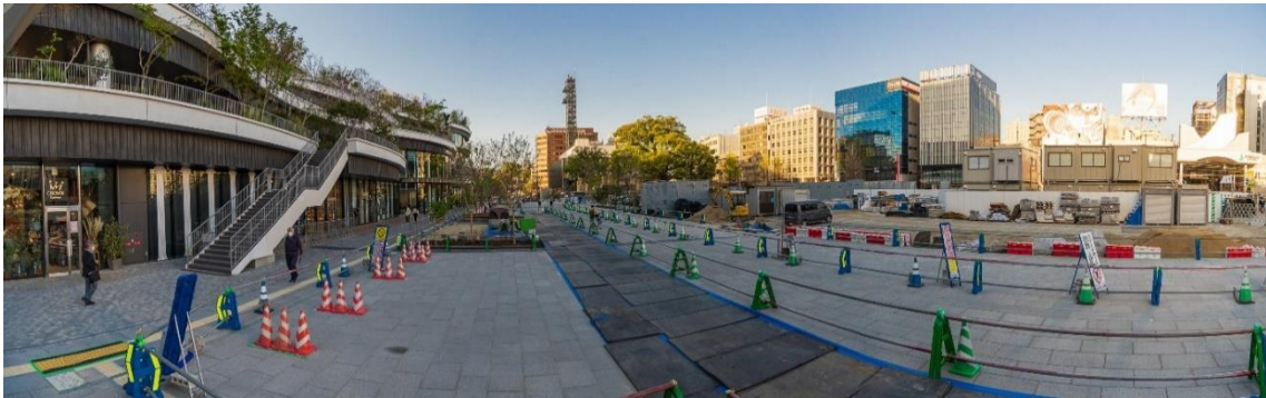
施工中の状況 R3年3月時点
