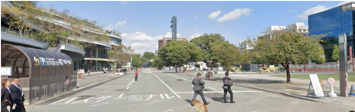
着工前の状況 R元年10月時点
