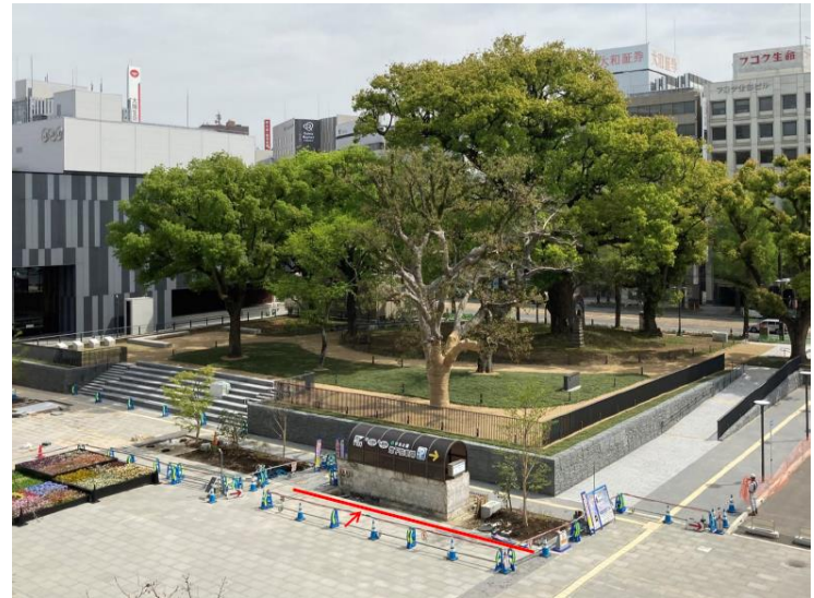
竣工 R3年3月
