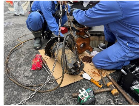
写真2_ポンプ清掃の様子
