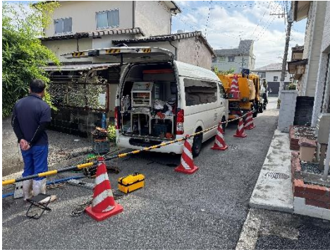
写真1_集水管清掃の様子
