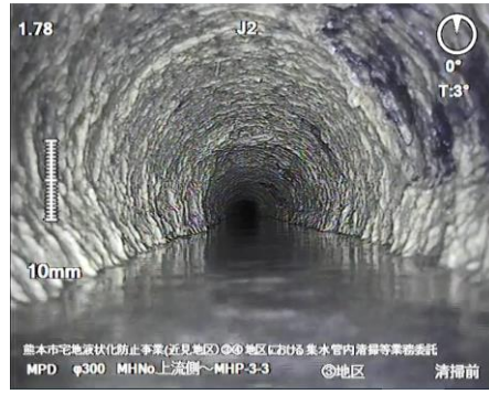
写真1_集水管清掃の様子
