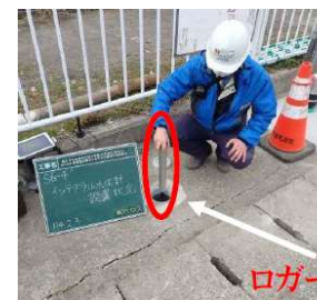
写真3. 水位計設置状況
