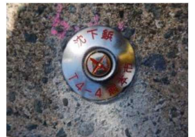
写真4. 沈下鉤設置状況
