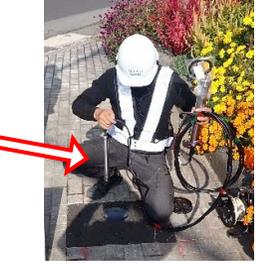
地面を削孔して地下水位を確認します。
