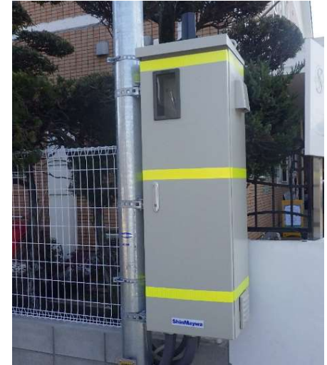
写真3. 制御盤設置状況
