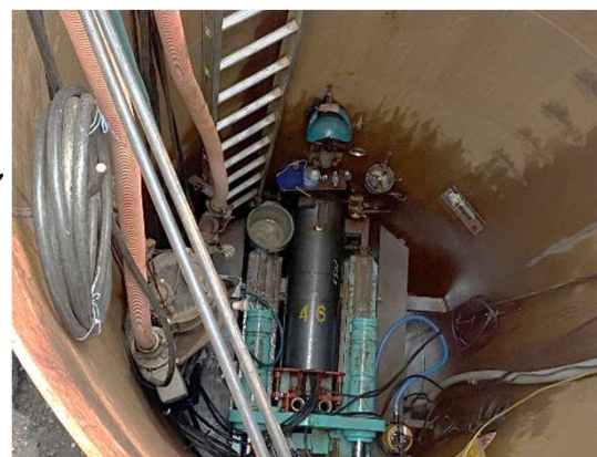
工事場所(1)の施工状況
