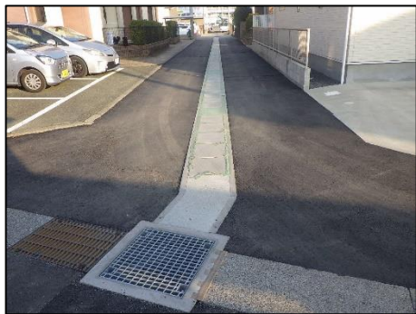
①地区側溝敷設完了写真
