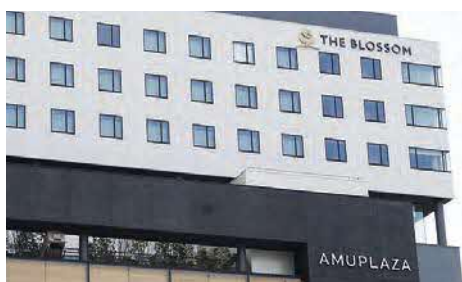
建築物と調和した大きさの壁面広告
