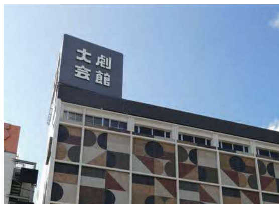
建物の色彩の一部を地色にした広告 ★
