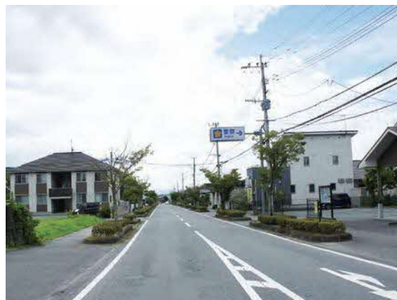
富合周辺の戸建住宅地景観
