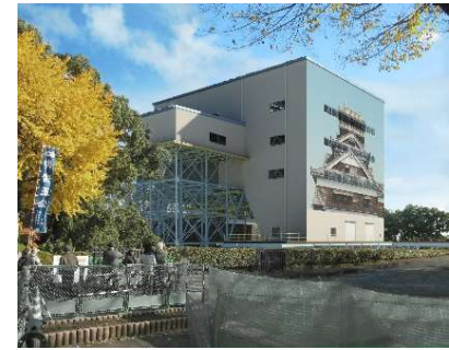
宇土櫓素屋根イメージ （西出丸北側から）
