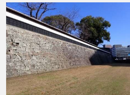
長堀復旧完了
