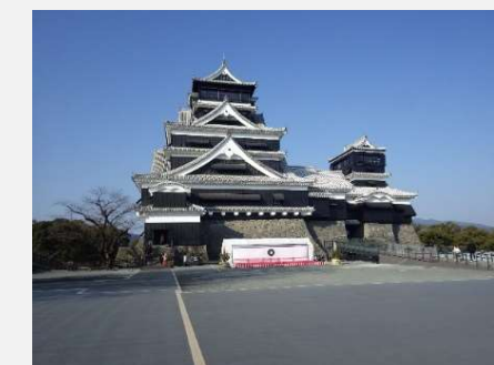
天守閣復旧完了
