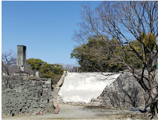
馬具櫓解体保存工事完了
