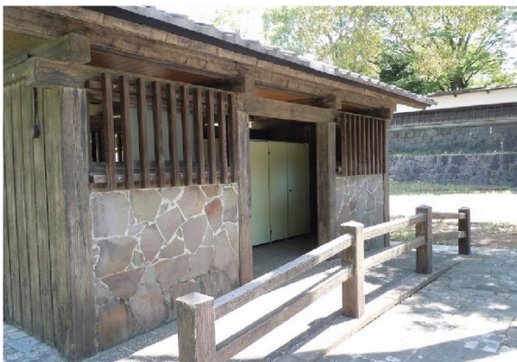
②③三の丸広場北側トイレ
