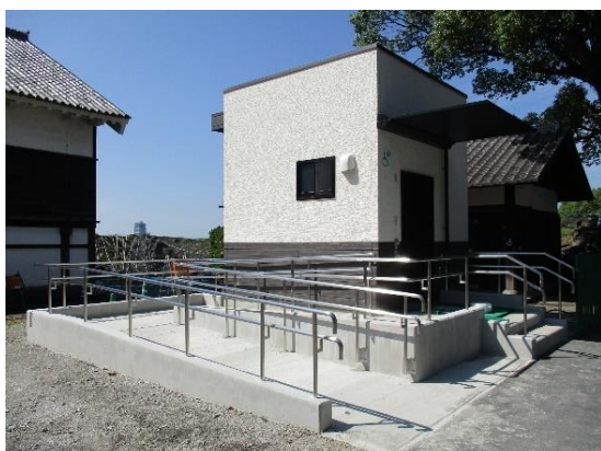
数寄屋丸多目的トイレ新設完了
