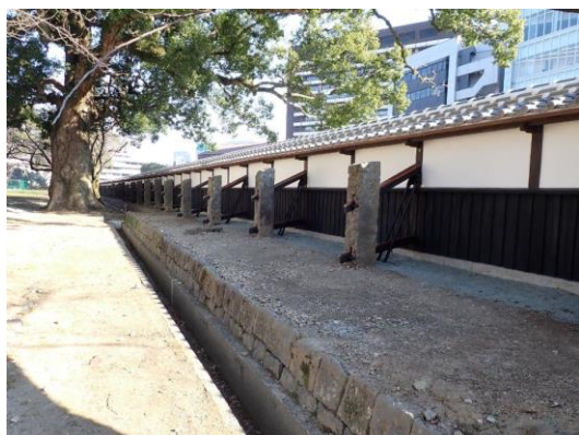
長堀復旧完了
