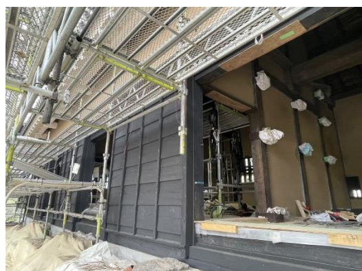
監物櫓組立工事状況
