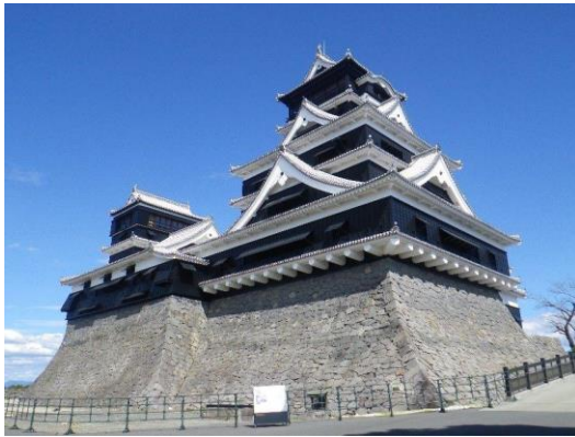
天守閣復旧完了
