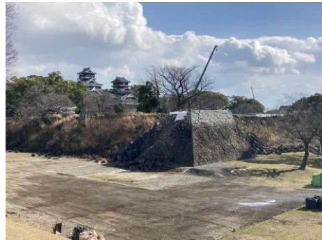
戌亥櫓解体保存工事完了
