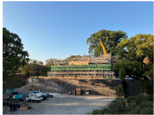
飯田丸五階櫓石垣復旧工事状況
