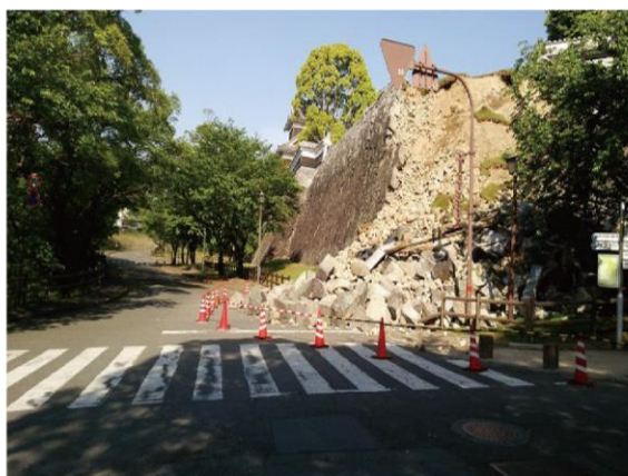
⑧奉行丸南東石垣の崩落
