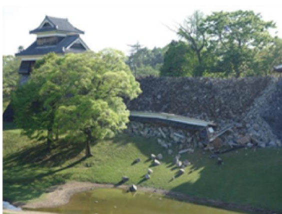
③西出丸西側石垣の崩壊
