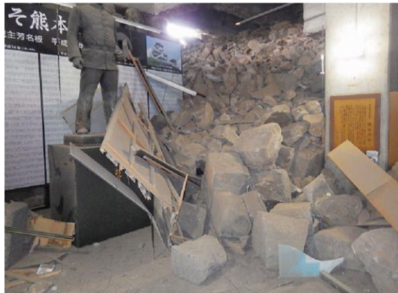
⑫ 小天守穴蔵石垣の崩落
