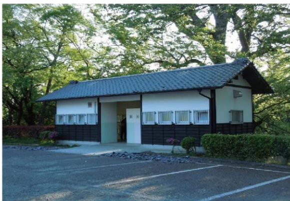
⑲ 二の丸駐車場西棟トイレ
