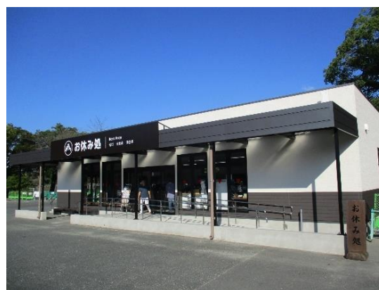
二の丸売店解体・ 二の丸仮設休憩所（北棟）新設完了
