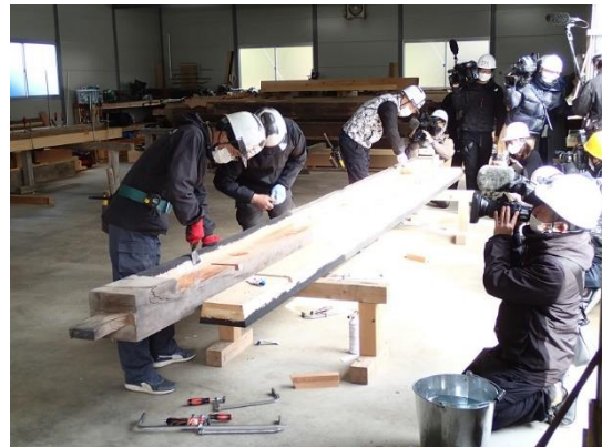
監物櫓での部材の繕い（2021）
