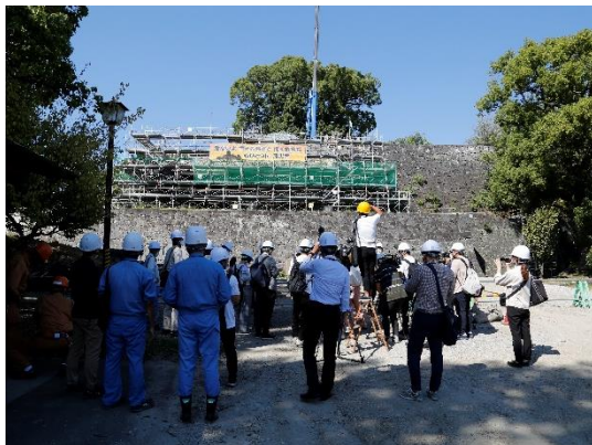
飯田丸五階櫓台石垣復旧工事（2022）
