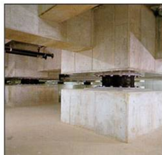
積層ゴム支承(免震材料)
