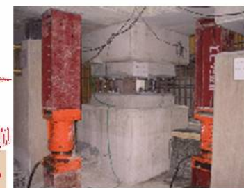
免震補強の例 (基礎免震)
