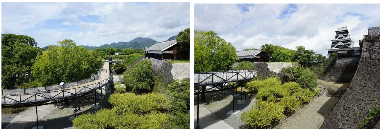
図 2-7-1 復旧中の熊本城を見学できる本丸エリアの特別見学通路
